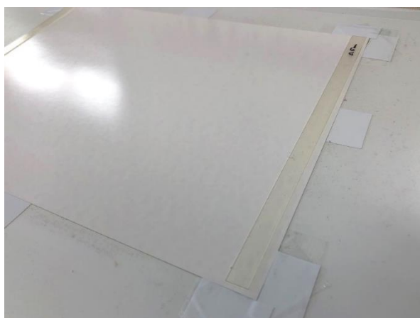
図5 スペーサーを配置した状態
