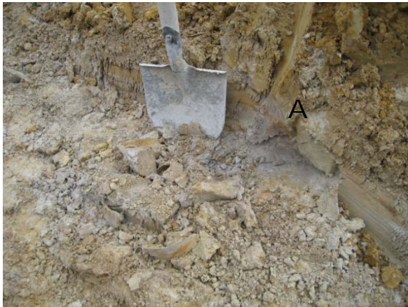
図2 有田町道（小溝原～穂波ノ尾線）の工事現場。
