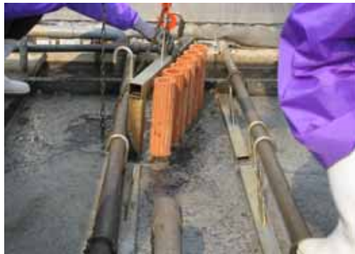
図2 MAP 反応槽への回収部材の設置の様子
