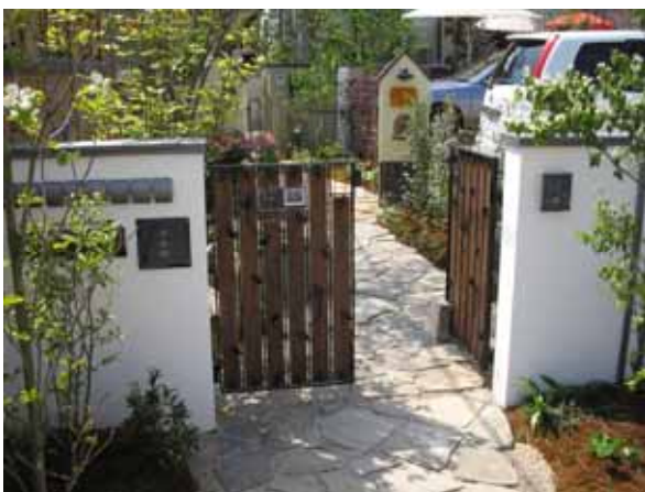
ブロック基礎による機能門柱
