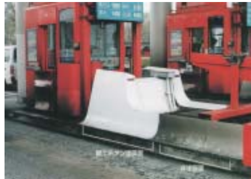
道路料金所の防汚。白い部分に施工。汚れの差がくっきり。(カタログから)
