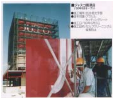
スーパー看板の防汚施工(カタログから)
