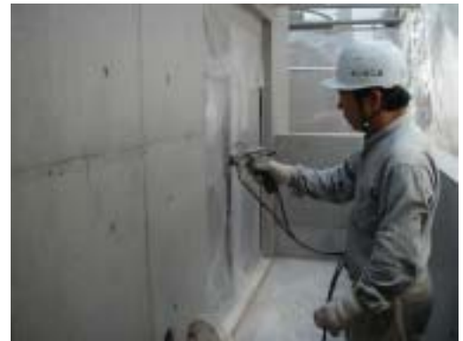
ビル外壁への現場施工 スプレーなどで行います。
