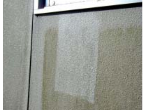
カビも分解します！ カビの生えた一般住宅裏壁の一部分に塗布して2ヵ月後。（窓の下の四角い白い部分がコーティングしたところ）
