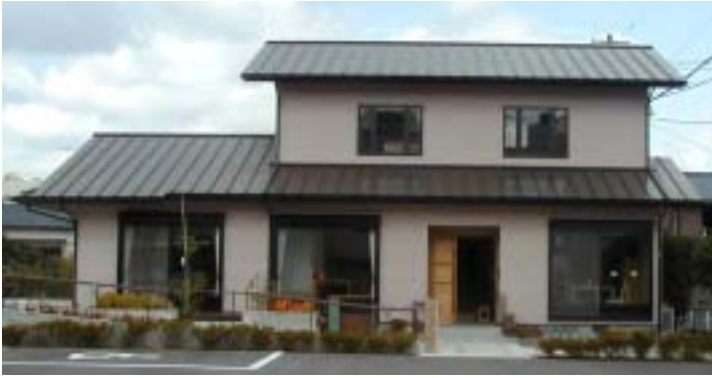
バリアフリーモデル住宅（佐賀市内）の壁へのデモ施工。
